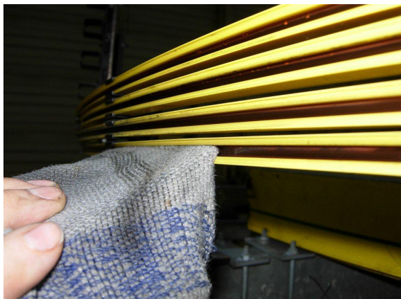
図 10 : クリーニングツールの角度を変えて各部位をまんべんなく清掃する
